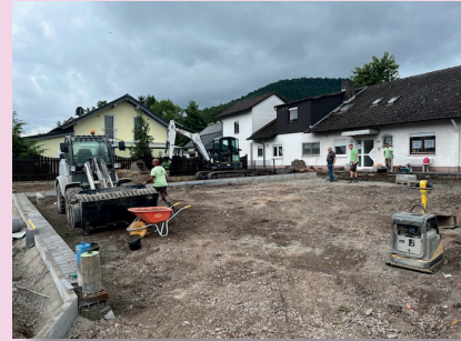
Bauarbeiten im Juni 2024 zur Errichtung des barrierefreien Zugangs
